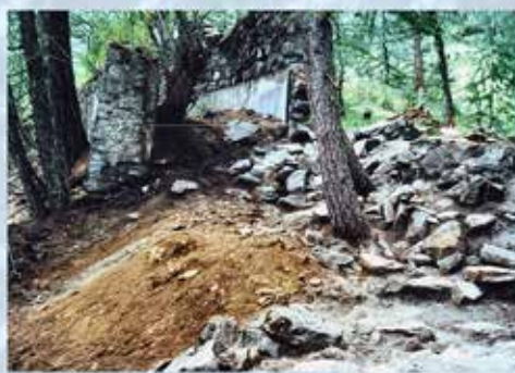
Parte terminale del canale della centrale idroelettrica (1890).
