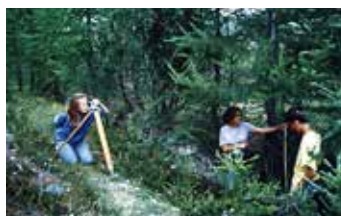
Rilevamento del canale idraulico e della sua pendenza.
