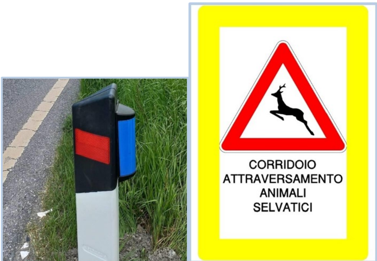
Figura 7 - Catadiottri blu per la dissuasione di ungulati all'attraversamento stradale e cartello di pericolo
