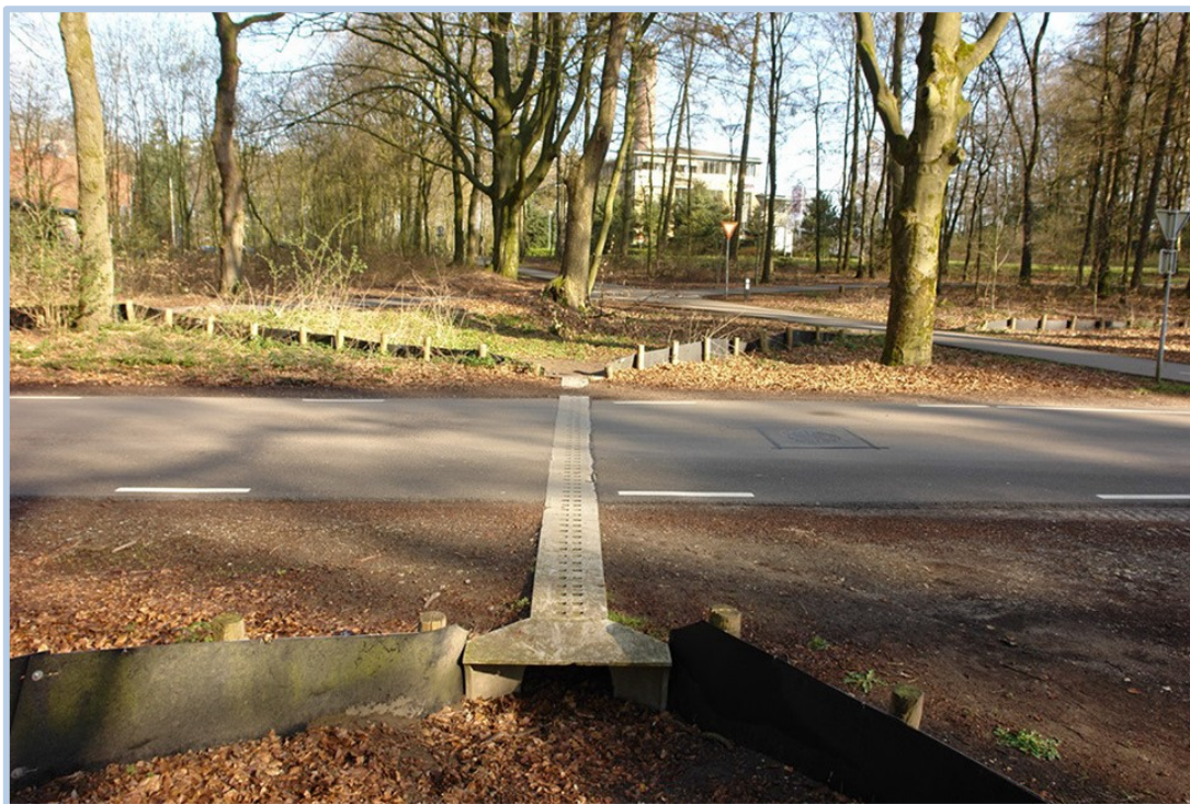
Figura 4- Barriera ed invito per un rospodotto in Ede (Paesi Bassi) realizzato con taglio del manto stradale e con manufatto forato per l'illuminazione naturale del tunnel
