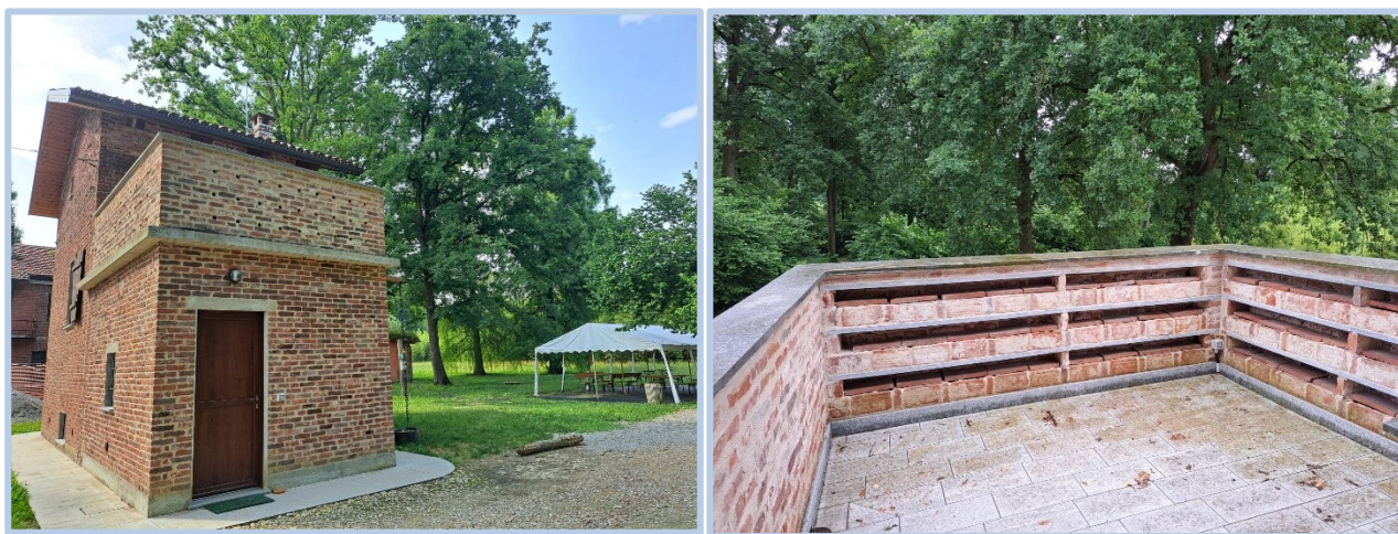
Figura 8 - Esempio di ristrutturazione virtuosa con costruzione di passerère lungo la muratura di un terrazzo (Candiolo, TO)
