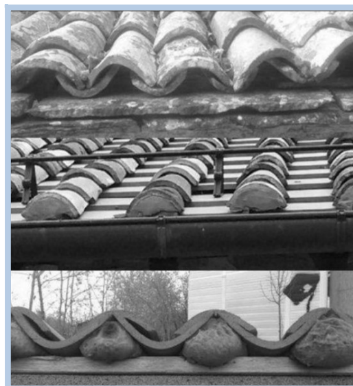
Figura 5 - I coppi non sigillati (in alto) sono una grande risorsa per i rondoni e sigillarli con malta (al centro) o con poliuretano (in basso) causa mortalità ed esclude per sempre piccole specie animali (Fonte: Ferri M., 2018)
