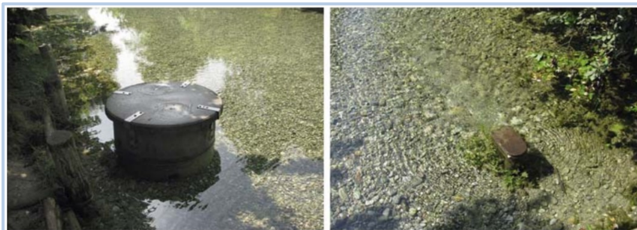
Figura 6 - Tini in cemento con copertura e tubi metallici commerciali adattati
