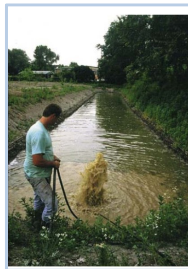
Figura 7 - Spurgo con immissione di aria compressa nelle tubazioni.
