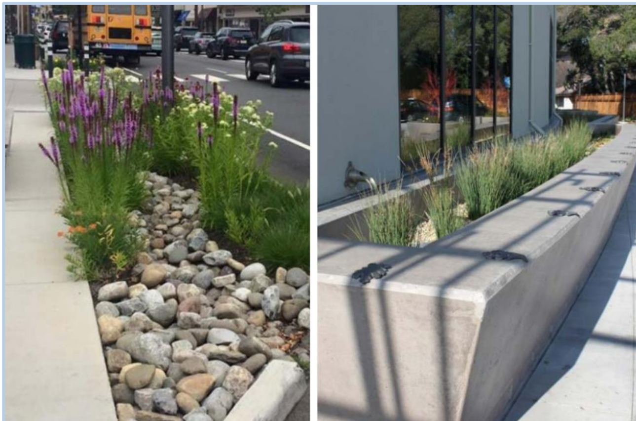
Foto di aiuole di bioritenzione: a sinistra posta tra il marciapiede e la carreggiata, a destra progettata nella forma della vasca rialzata a filtrare l'acqua meteorica raccolta dalle grondaie di un edificio (fonte: Bonsignori R. et al., 2022)
