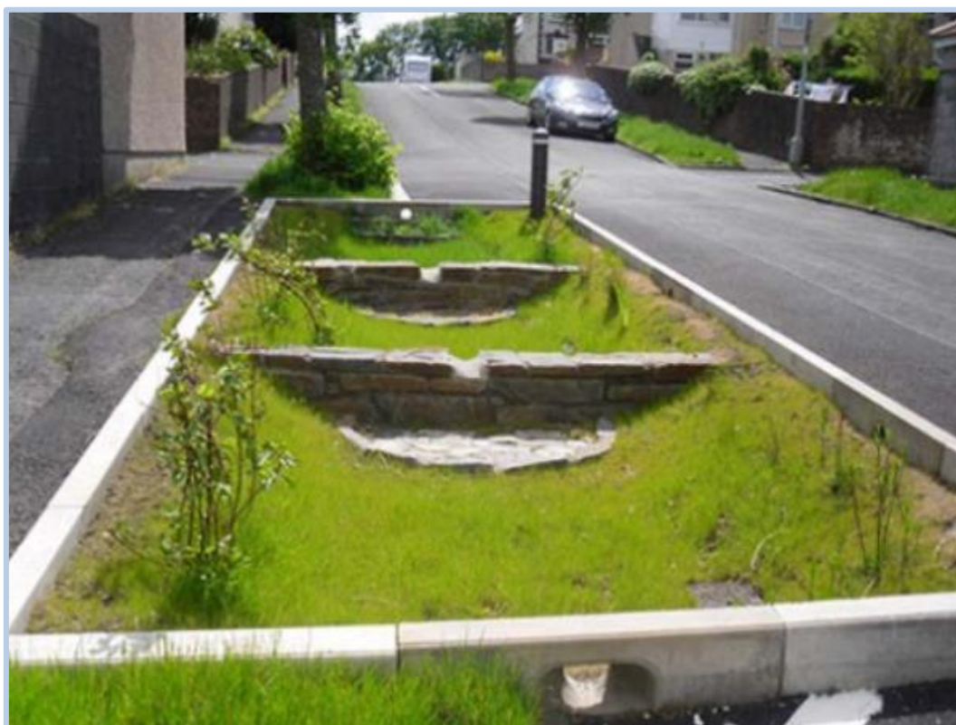
Canale vegetato con dighe di controllo in muratura (fonte: Bonsignori R. et al., 2022)
