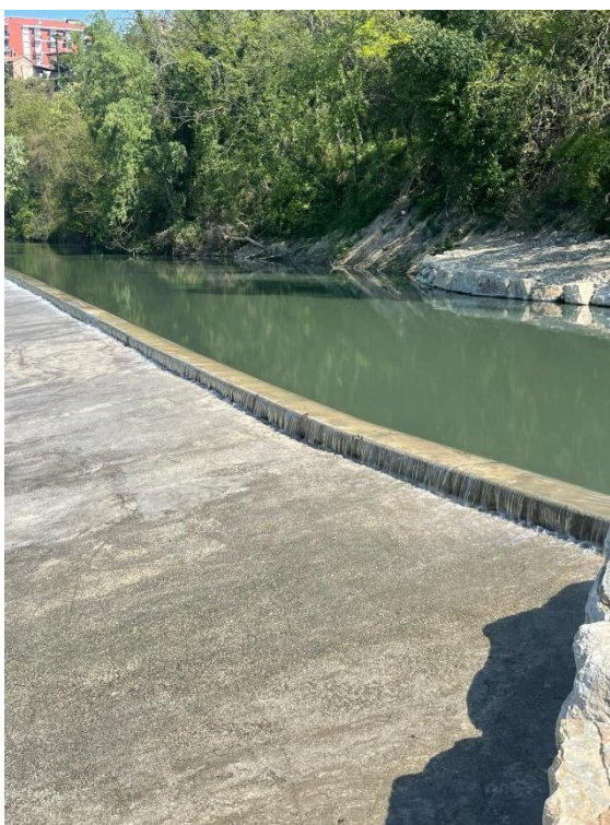
Traversa fluviale nel tratto compreso tra la sponda sinistra e la parte mediana. Questo tratto è stato completamente rifatto mantenendo inalterata la quota del coronamento della traversa.
