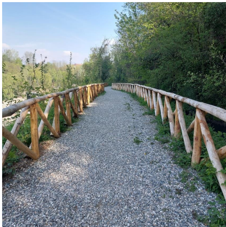
Pista ciclo pedonale oggetto di importanti interventi di compensazione quali fondo, cordolatura laterale e recinzione rustica ai fianchi nel tratto di scarpata compreso tra la rampa di accesso alla centrale e il canale di Venaria. Sul lato sinistro oltre la staccionata si vedono in primo piano gli alberi di carpino oggetto di nuova piantumazione
