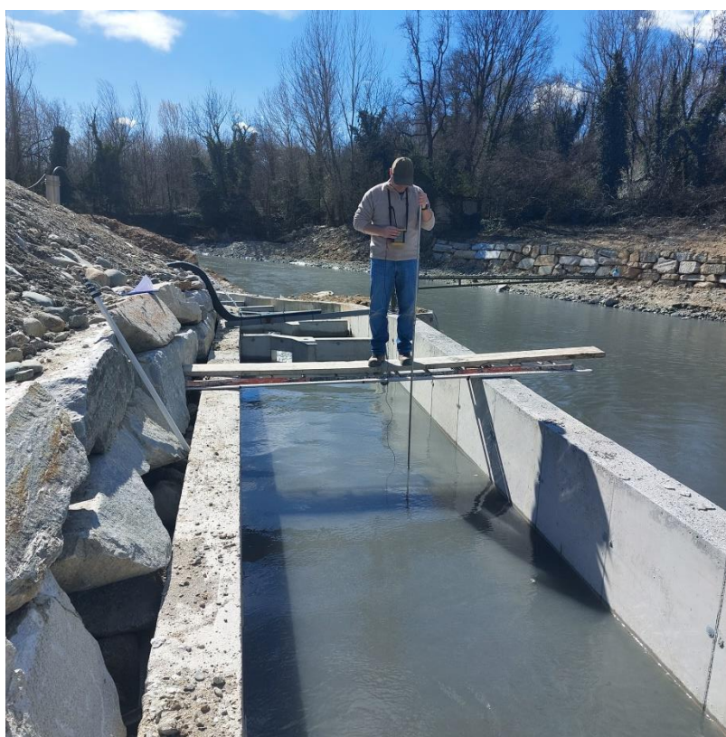
In primo piano la scala dell'ittiofauna in sinistra orografica. Sullo sfondo è ripresa la scogliera in massi a protezione della sponda destra orografica.
