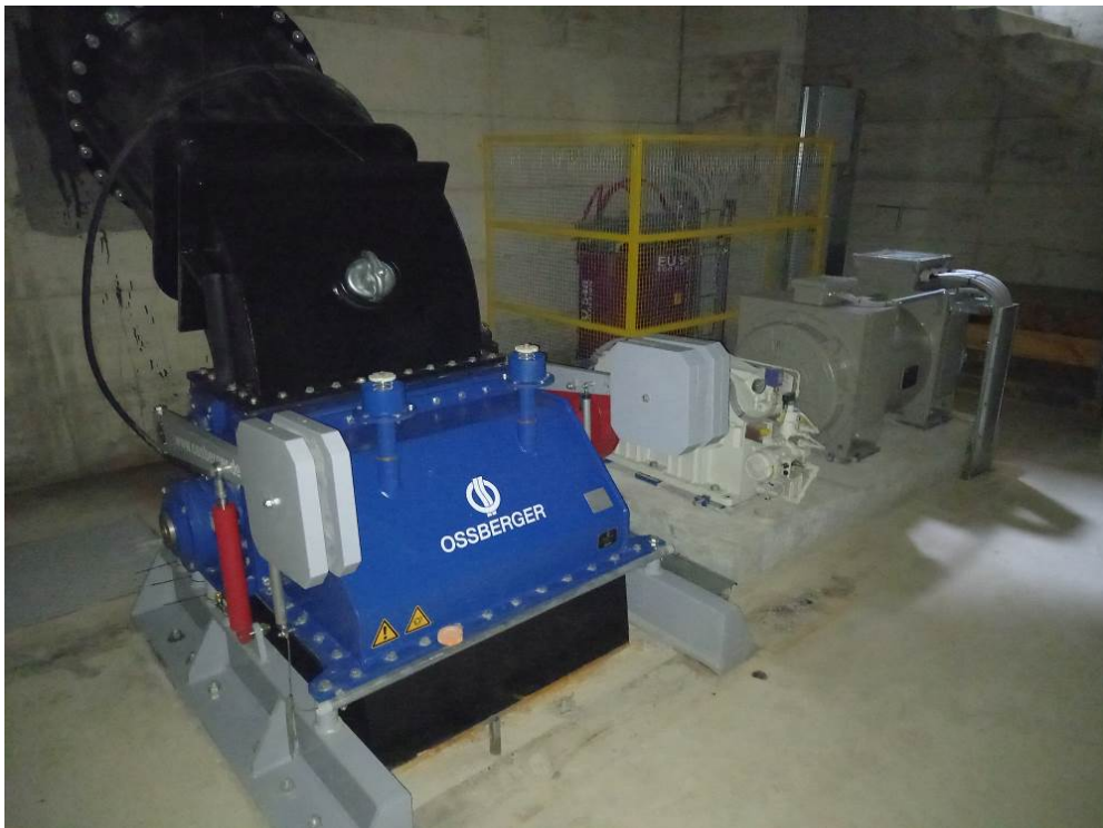
(Fotografia 5 –Fabbricato centrale - Locale macchine – Turbina Moltiplicatore e Generatore)
