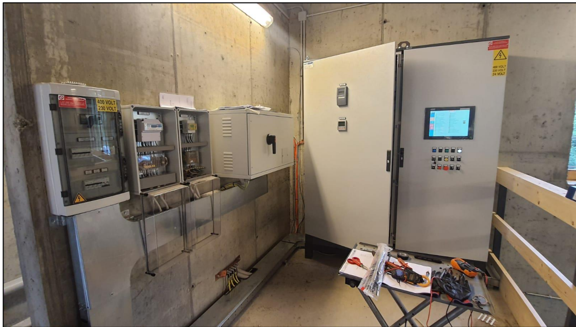
Figura 4 – Quadri elettrici del locale tecnico della centrale
