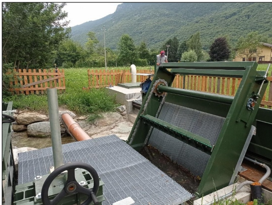
Figura 6 –Sgrigliatore che precede la vasca di carico
