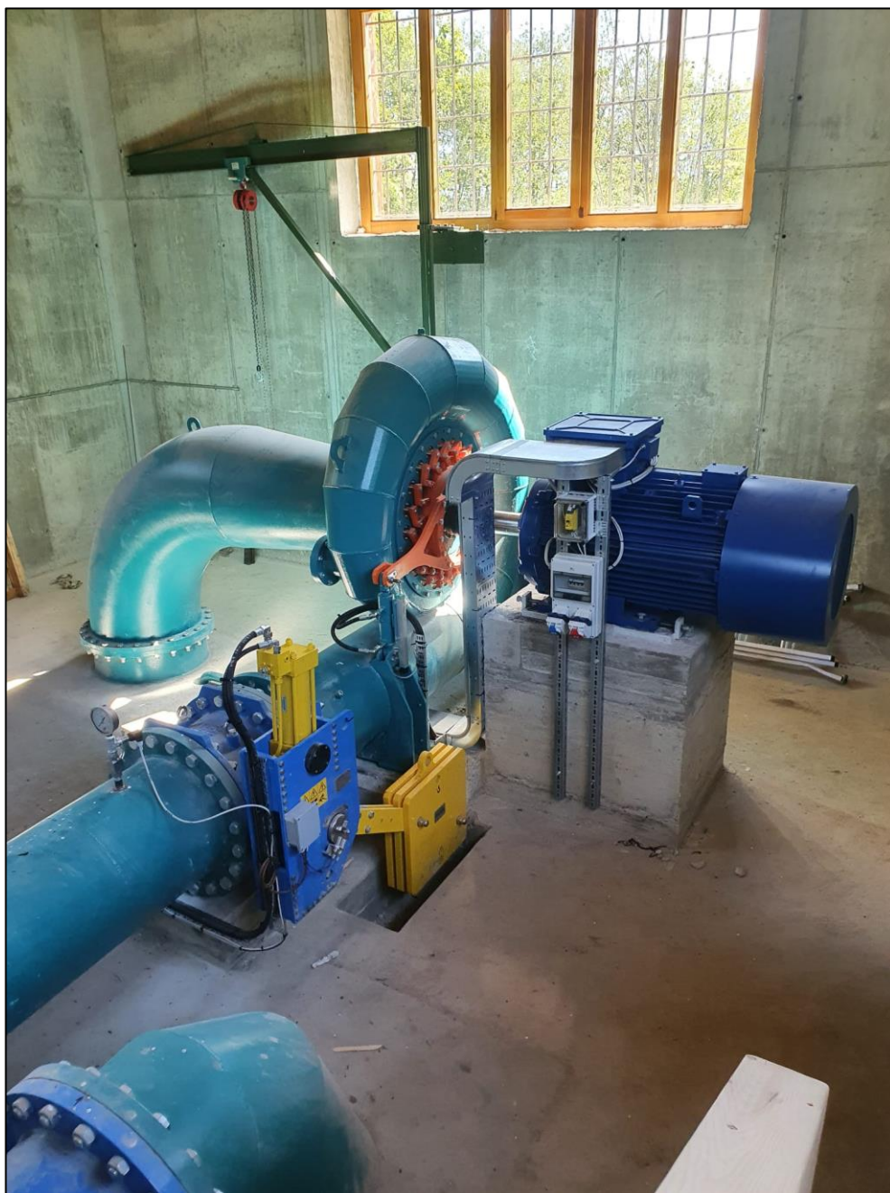
Figura 14 – Turbina e generatore della Centrale
