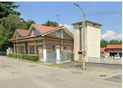
28 - Cabina esistente MT/BT "Azzario Staz" di arrivo della nuova linea con cavo interrato 3x1x240 mmq Al in sostituzione del cavo interrato esistente
