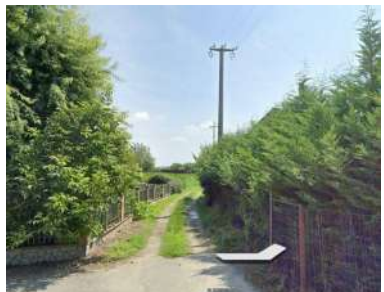
30 - Linea esistente a fili nudi da sostituire con cavo aereo 3x1x95 mmq Al
