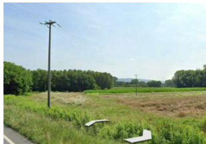
32 - Linea esistente a fili nudi da sostituire con cavo aereo 3x1x95 mmq Al
