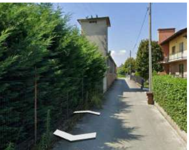
29 - Cabina esistente MT/BT "Baro" da cui si diparte nuova linea aerea in cavo 3x1x95 mmq Al in sostituzione ai fili nudi
