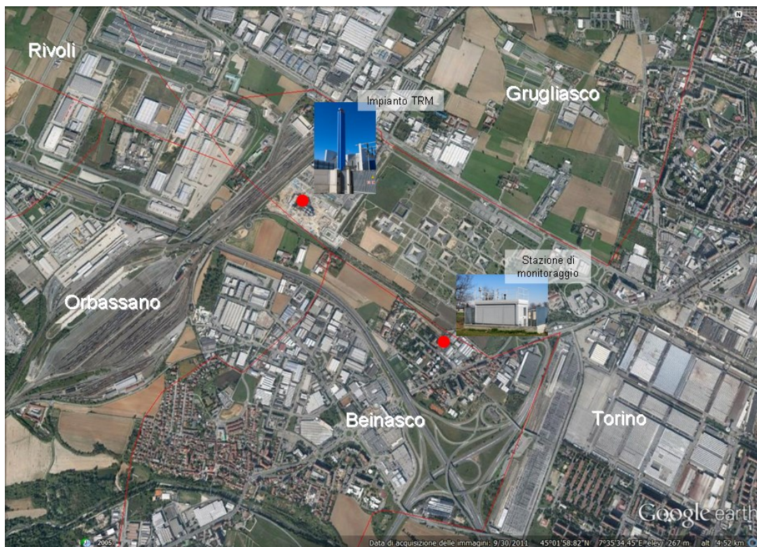
Figura 1 Ubicazione della stazione di monitoraggio e dell'impianto TRM
