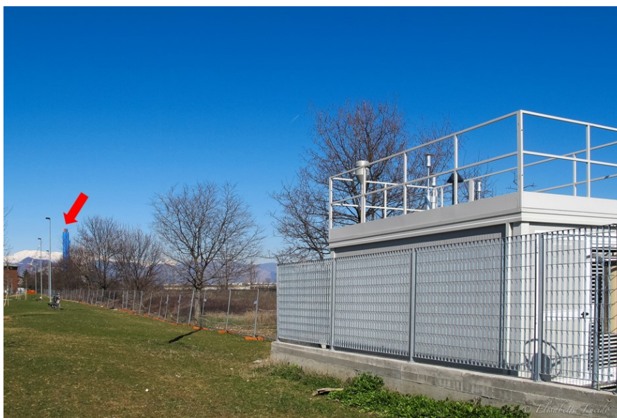
Figura 2 - Vista della stazione di monitoraggio (sullo sfondo l'impianto TRM)
