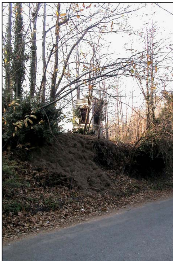
Figura 98: vista dalla strada per Costagrande
