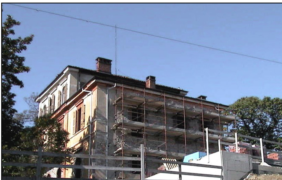
Figura 60: fronte principale coperto dall'impalcatura
