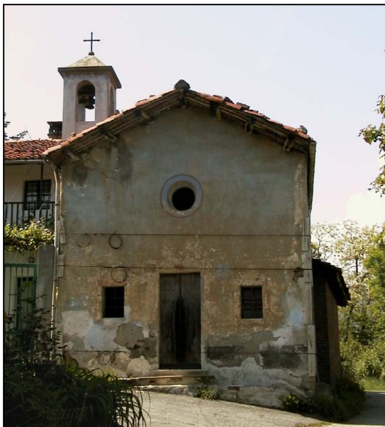
Figura 91: vista da ovest (strada "ai Losani)
