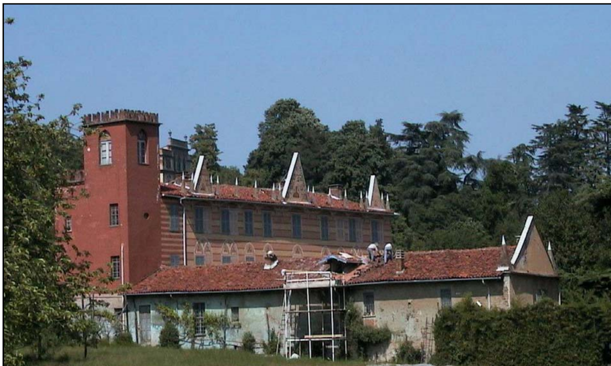
Figura 37: edificio padronale (sullo sfondo: villa Frisetti)
