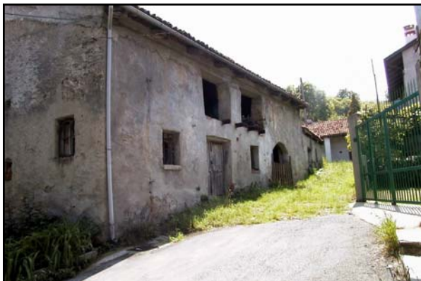
Figura 119: vista verso le strade interne del Nucleo
