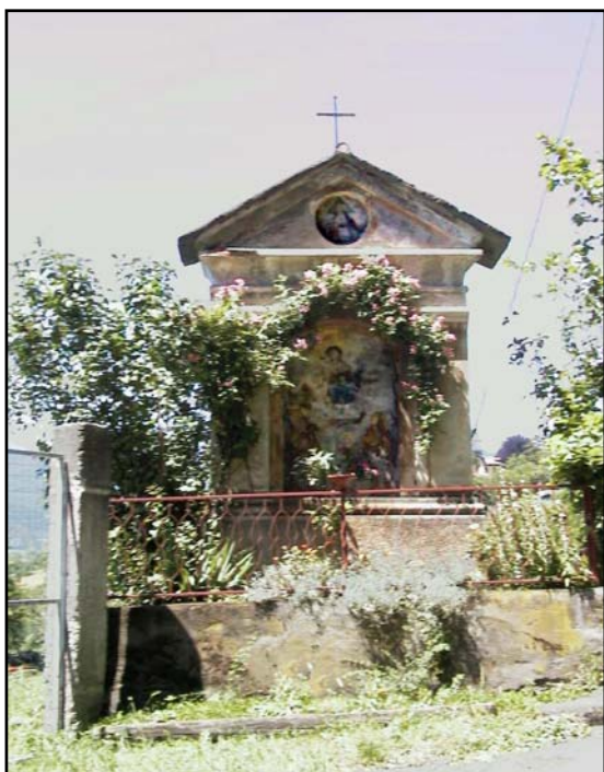
Figura 105: vista dalla strada per Costagrande
