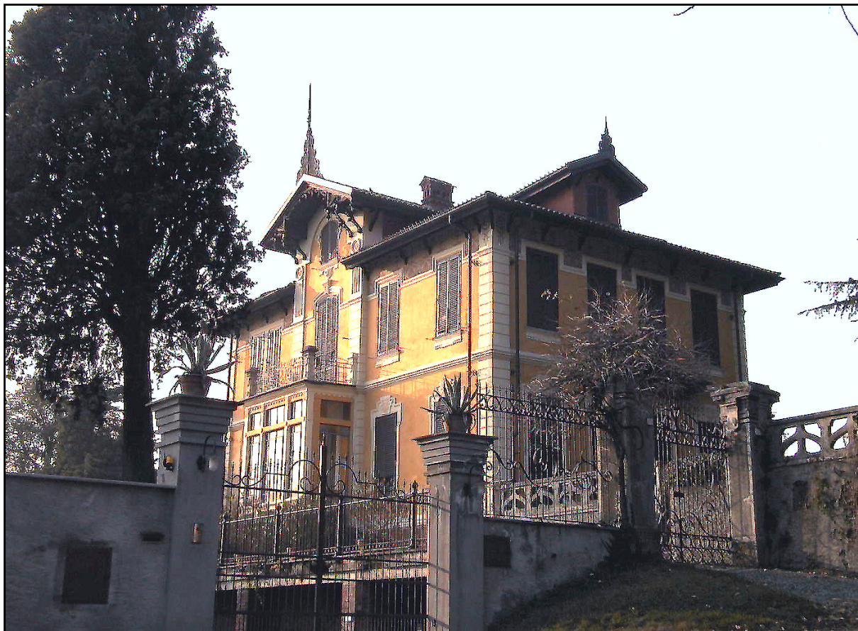
Figura 54: vista dalla strada per Costagrande
