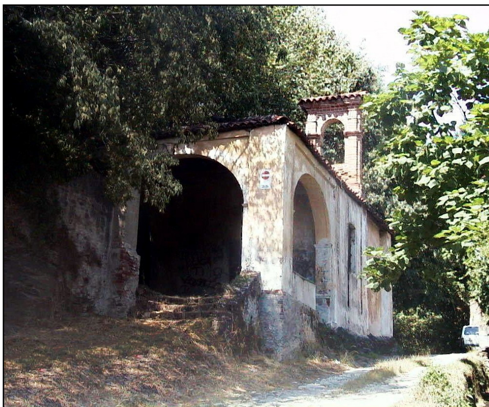
Figura 27: Cappella Santa Lucia e strada laterale di accesso
