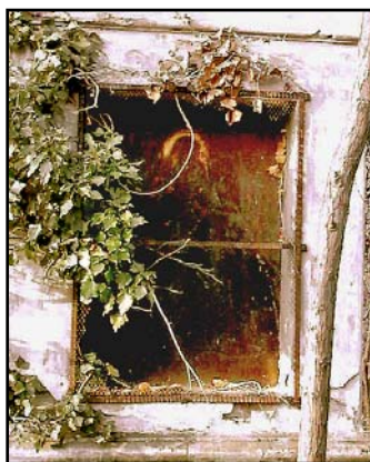
Figura 99: particolare del dipinto sul fronte principale, verso strada per Costagrande
