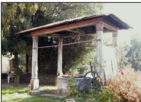
Figura 46: pozzo nel cortile interno
