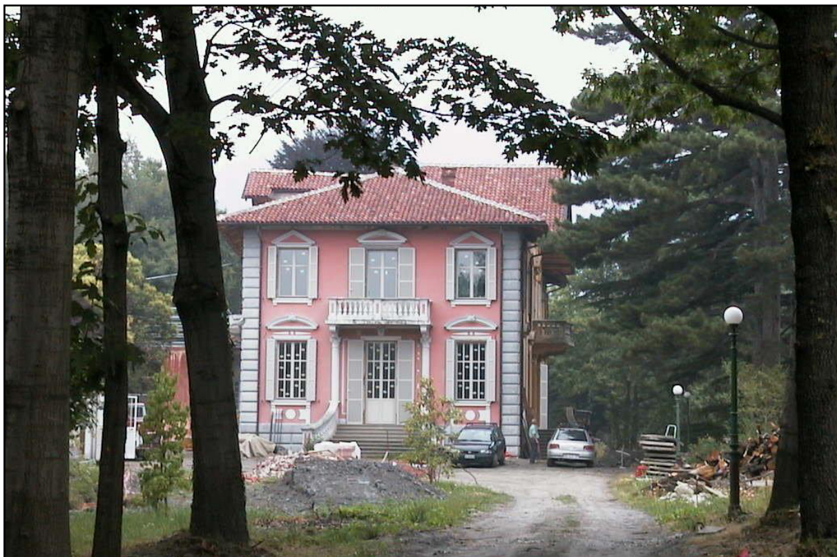
Figura 72: edificio padronale. Fronte laterale rivolto verso l'attuale accesso principale
