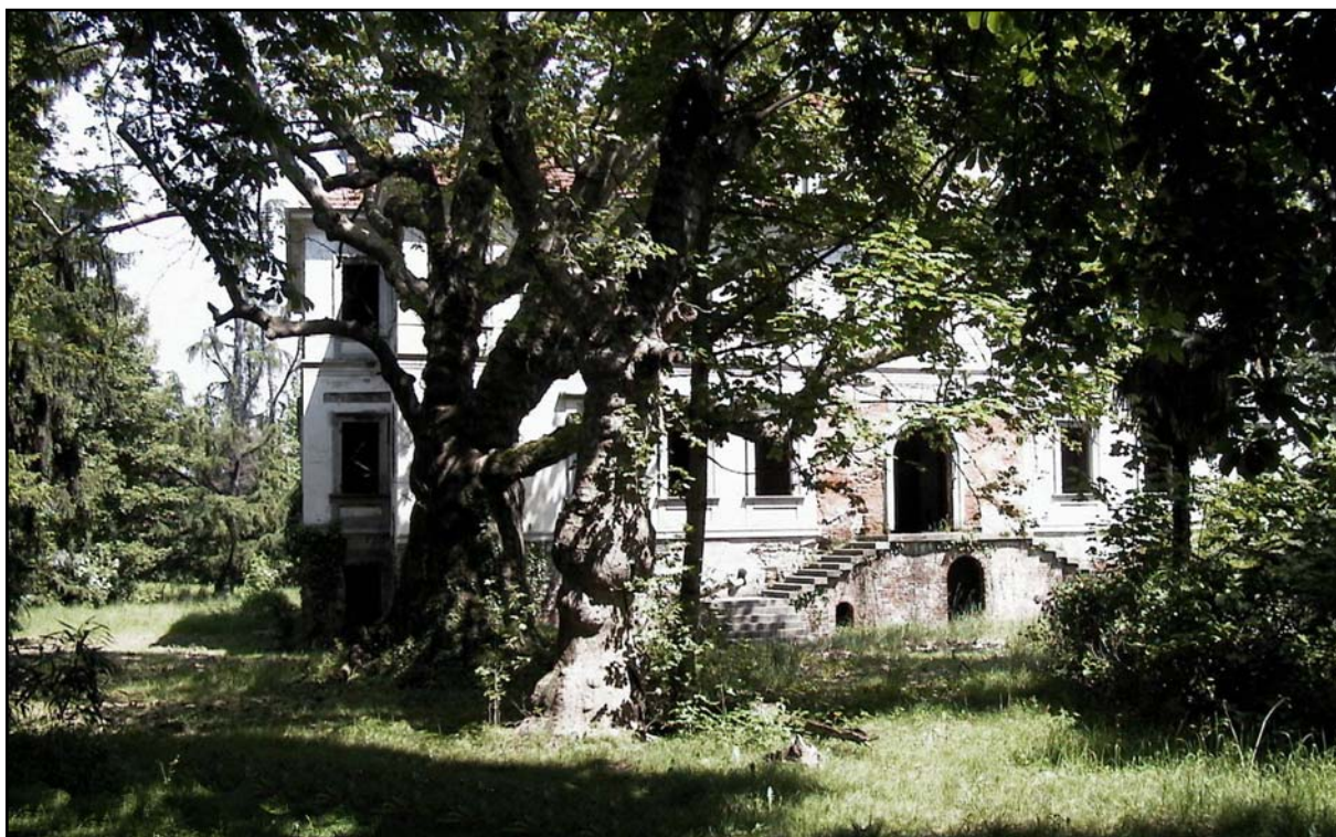
Figura 56: fronte principale con affaccio sul parco
