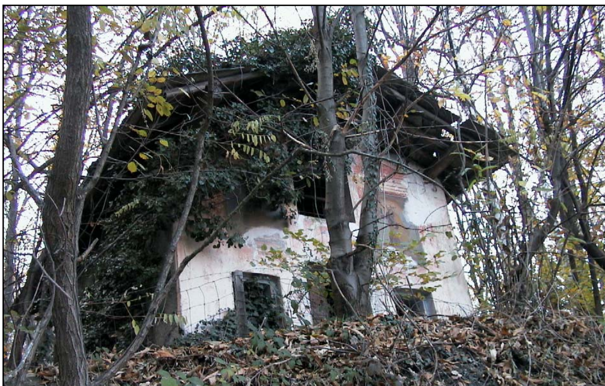
Figura 86: fronte principale, vista dalla strada
