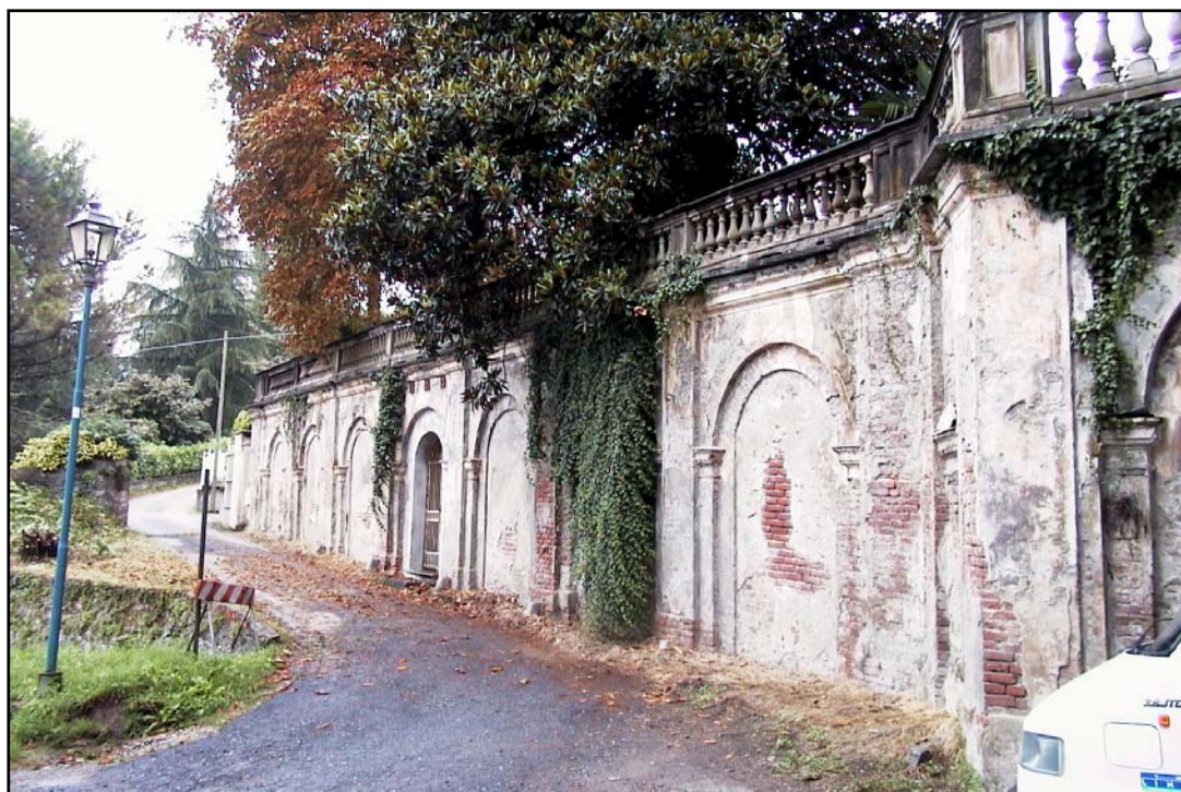
Figura 53: muro di contenimento con balastra su strada
