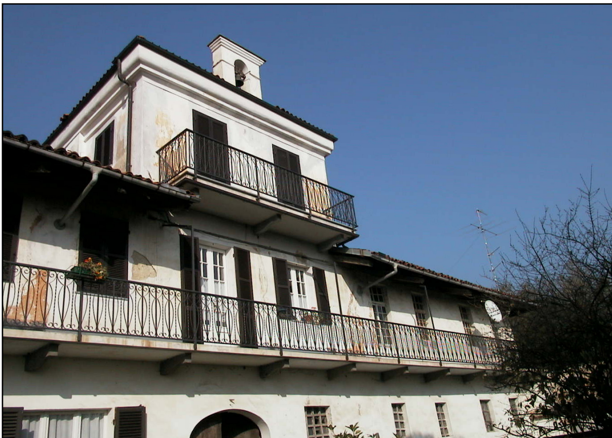
Figura 44: facciata principale, sul cortile interno
