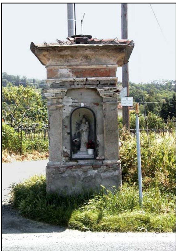
Figura 92: fronte principale rivolto verso la S.P. 167
