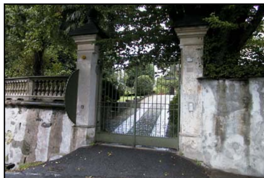
Figura 52: balastra su strada
