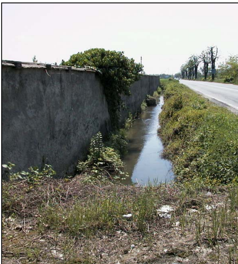
Figura 80: antica bealera che corre lungo la strada statale e costeggia la cascina (ovest).
