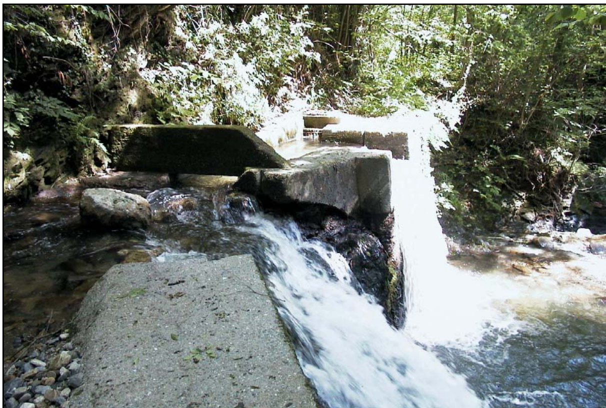
Figura 81: opera di presa sul torrente Lemina
