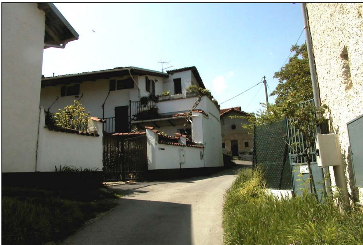
Figura 118: nucleo rurale “I Losani”, vista da strada ai Losani
