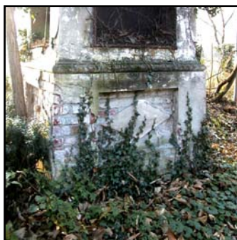
Figura 100: particolare del basamento (fronte est)
