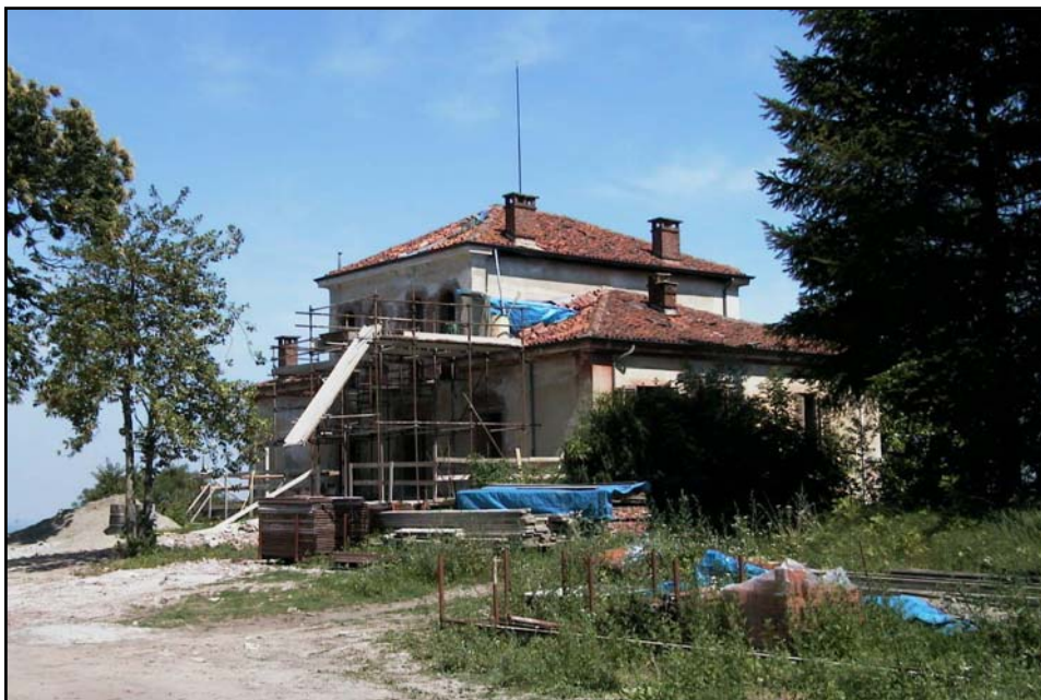
Figura 59: vista d'insieme (con impalcatura)
