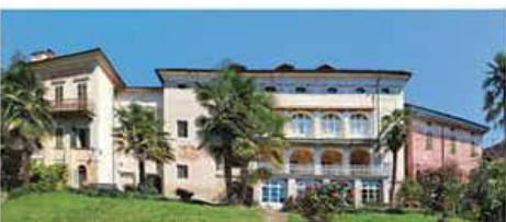
PALAZZO RICCA DI CASTEVICCHIO, Via Vitt. Emanuele, 15 - 10060 Bricherasio (TO)
