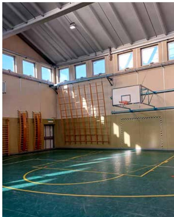
parapetti in copertura. È stata inoltre effettuata la sostituzione del policarbonato della copertura shed, con il conseguente miglioramento della sicurezza e dell'efficienza energetica della struttura.
