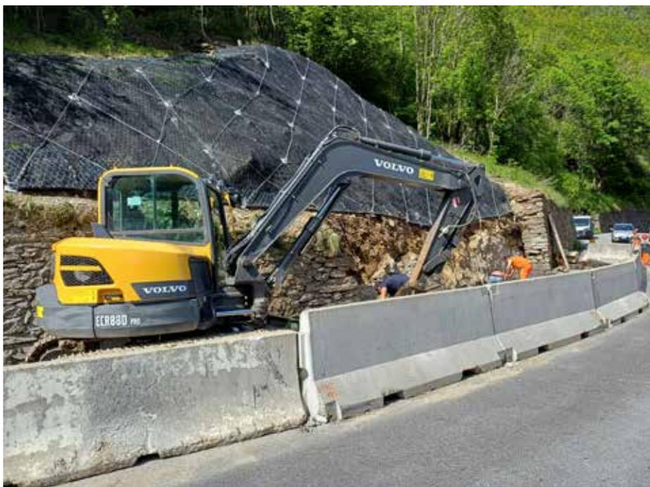
Sul posto sono stati installati i semafori per la regolazione del traffico. È in corso un intervento di somma urgenza per la stabilizzazione del terreno e delle rocce a monte della carreggiata. La percorribilità a doppio senso di marcia verrà ripristinata appena possibile.
