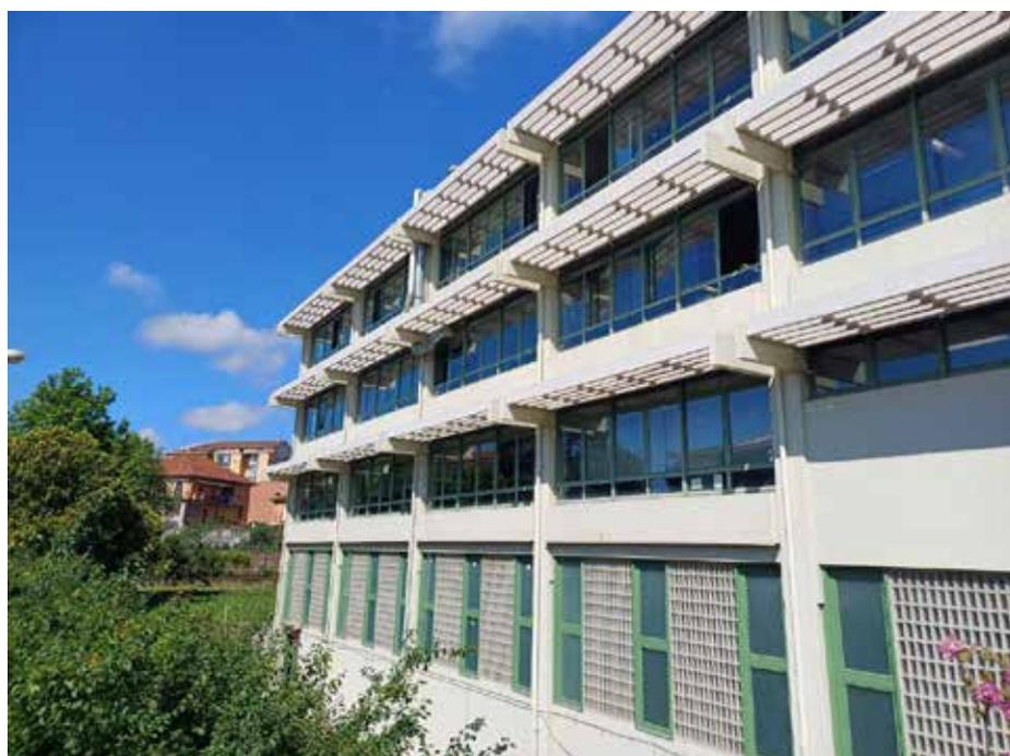
riguardato principalmente il risparmio energetico, con il rifacimento delle facciate, la sostituzione dei serramenti, il rifacimento degli impianti elettrici e l'utilizzo di lampade a led, ma sono anche state ricostruite alcune aule e rifatti diversi bagni.
