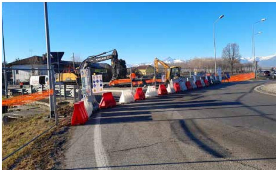
Si procederà con una prima realizzazione della rampa di accesso all'alveo e delle opere provvisorie di sostegno dello scavo dal lato di Virle, nelle vicinanze di un'abitazione privata.
