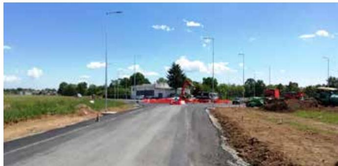
parte della segnaletica stradale verticale definitiva; contestualmente è già stata ampliata anche la viabilità di accesso alla discarica Sia del Comune di Grosso, con un nuovo rilevato stradale e con il primo strato della nuova pavimentazione stradale.
