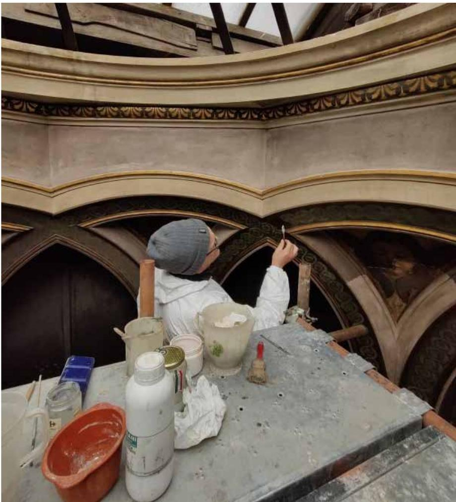
che provenienti dalla copertura superiore, ora sanata, che fortunatamente non hanno intaccato la struttura della volta, senza fratture nè cedimenti significativi, mentre la superficie pittorica è interessata da un processo di erosione e impoverimento, in alcune aree più superficiale in altre più profondo. Anche l'altare purtroppo non è in buono stato di conservazione.
