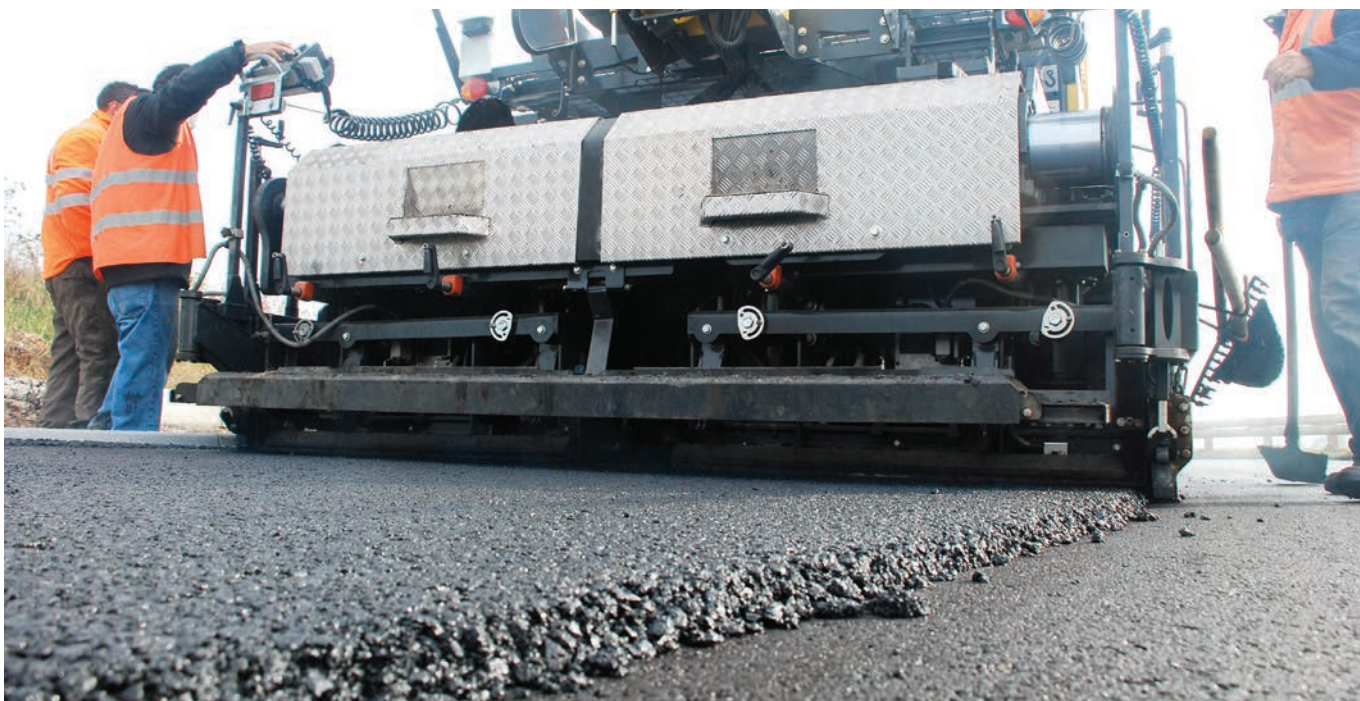
Si asfalta utilizzando il polverino ricavato dai vecchi pneumatici (Progetto europeo Tyrec4LIFE)
