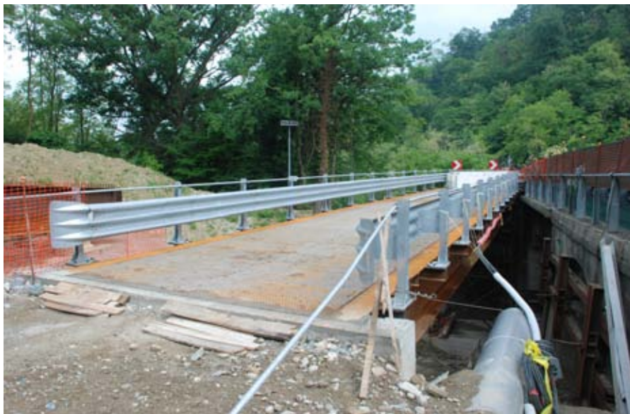
Lavori al viadotto di Pino Torinese
