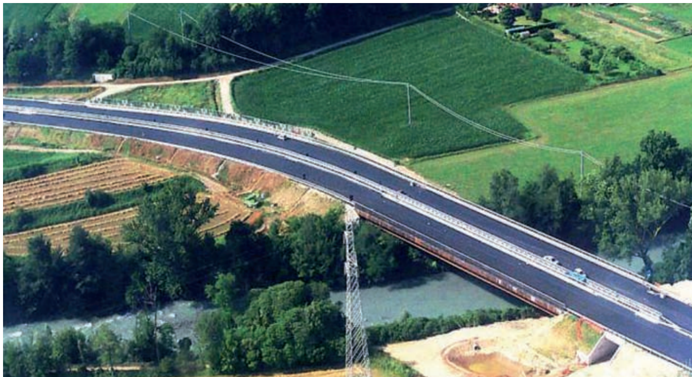
Il nuovo ponte sulla Dora a Collegno
