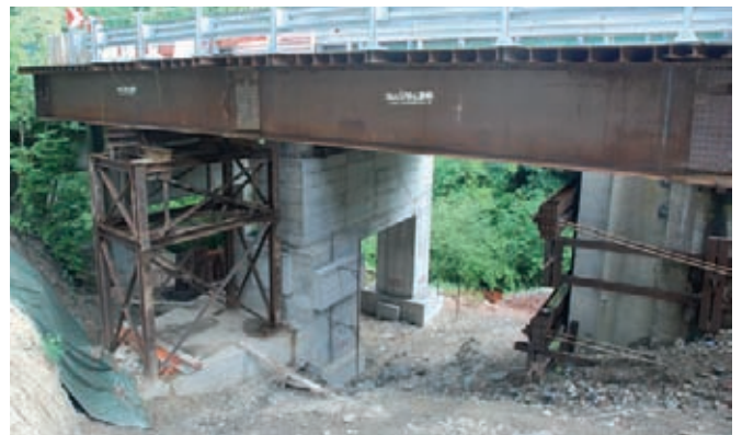
La costruzione del viadotto a Pino Torinese
