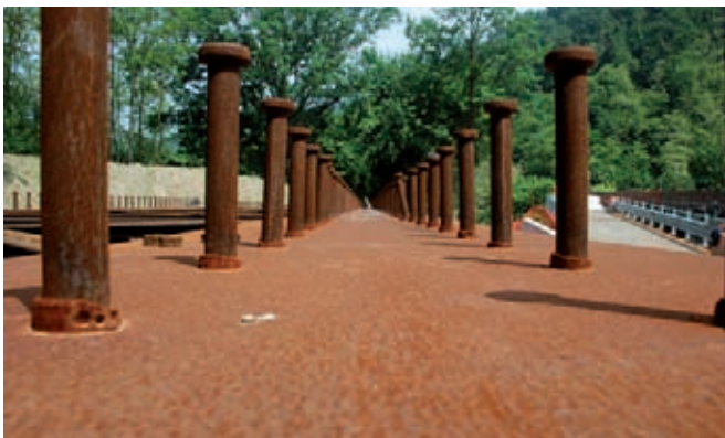
La costruzione del viadotto a Pino Torinese
