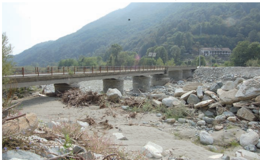
Il ponte sul Pellice dopo l'alluvione
