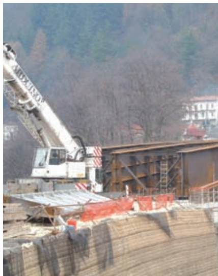
Lavori sulla provinciale 156
