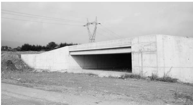
Lavori alla variante di Pianezza
