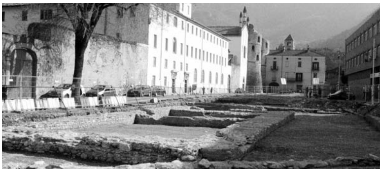
Lavori in piazza Savoia a Susa
