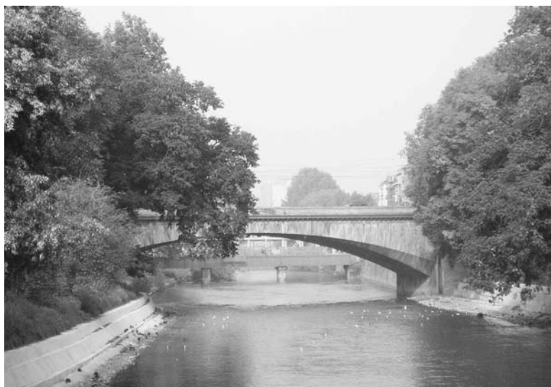
Il Ponte Mosca
