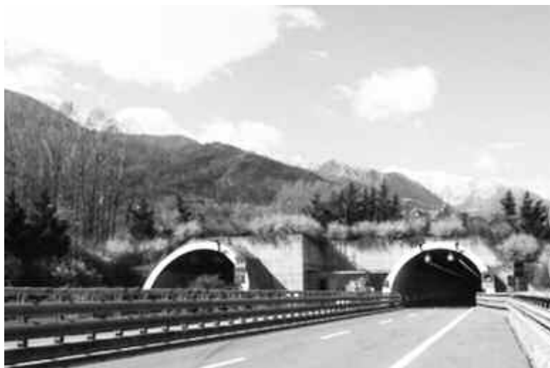
Galleria Prapontin, autostrada della Valle Susa
