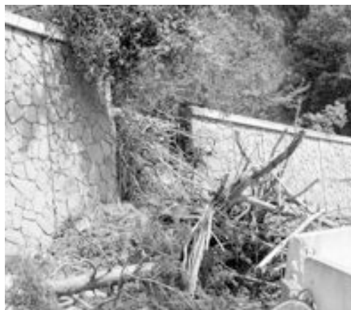
I danni dell'alluvione
