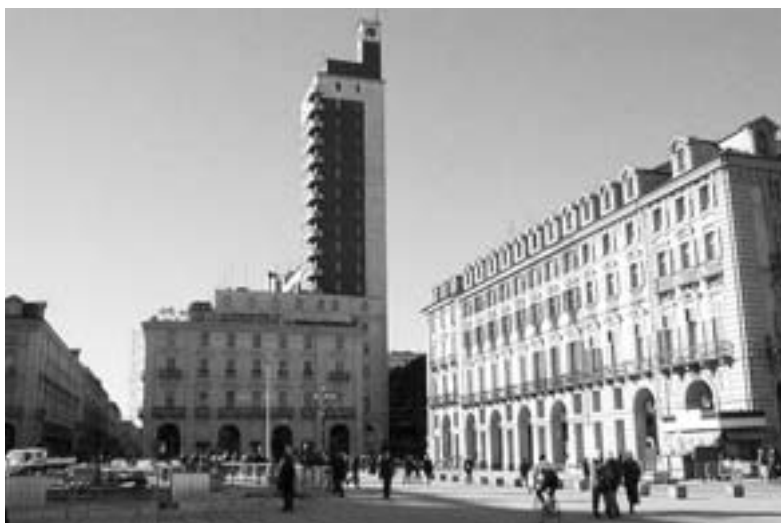
La Torre Littoria è il più alto edificio residenziale di Torino, contando 19 piani e 109 metri d'altezza. Fu realizzata dall'architetto Armando Melis tra il 1933 ed il 1934
