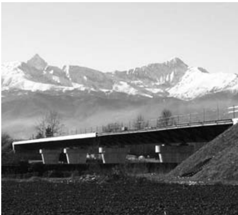
Il nuovo ponte sul Chisone
