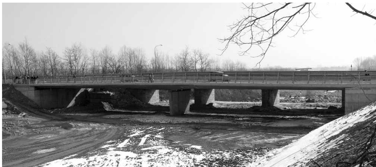
Nuovo ponte sul torrente Sangone lungo la S.P. 143 di Vinovo. Foto AFPT
