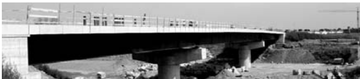
Opere di compensazione Ativa: il ponte sul Sangone
