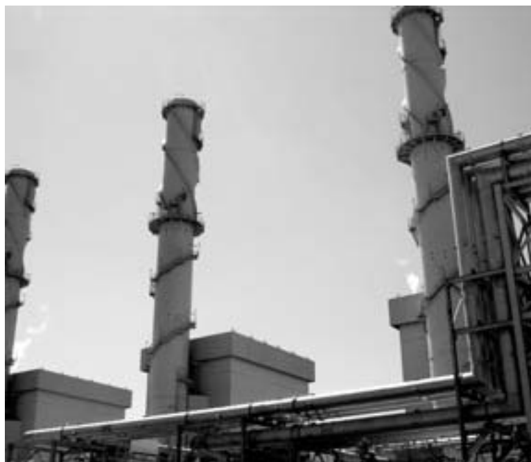
La centrale Edipower di Chivasso
