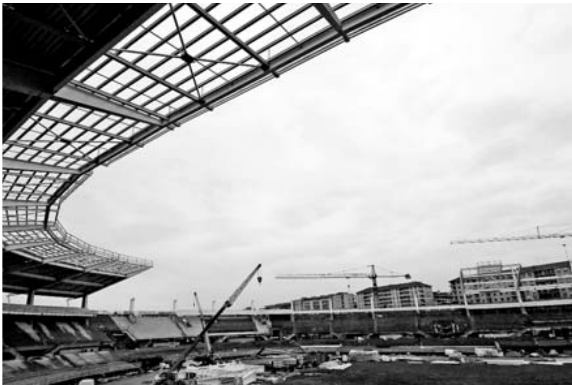
© Gian Mattia D'Alberto / LaPresse 11-04-05 Torinosport varie avanzamento lavori allo Stadio Comunale nella foto: panoramica dello stadio
