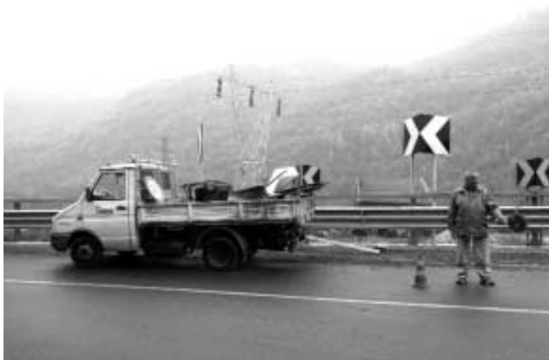
Lavori lungo le strade provinciali. Foto AFPT
