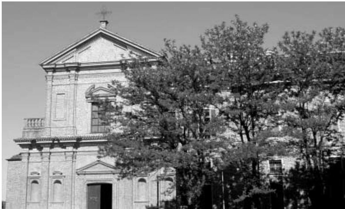
Abbazia di Casanova: facciata della chiesa
