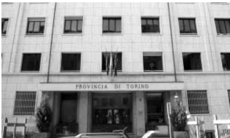
Lo stabile di Via Valeggio 5. Foto AFPT
