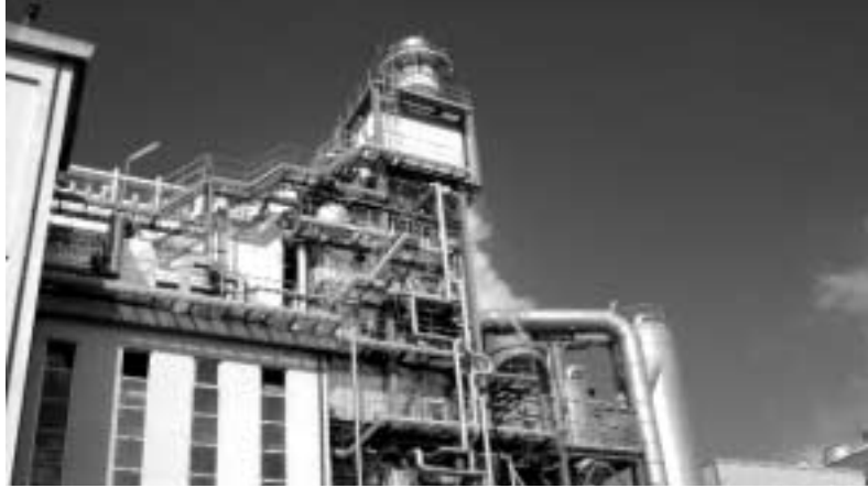
Termovalorizzatore produzione vapore
