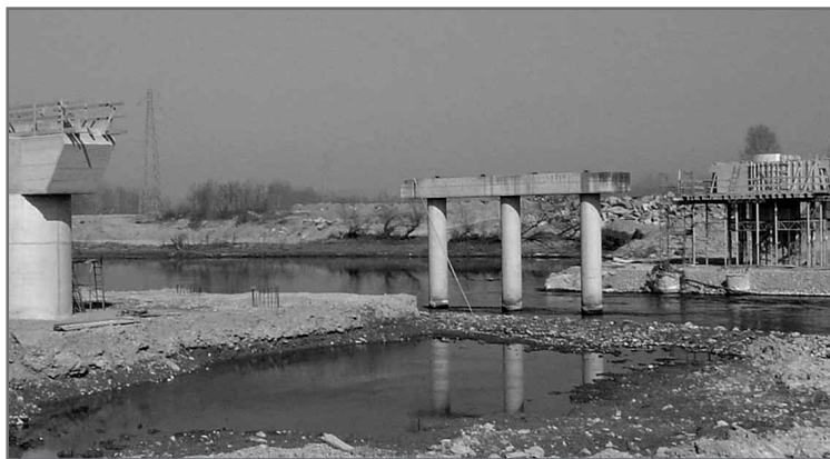
Il ponte in costruzione sul fiume Po tra S. Sebastiano e Verolengo
