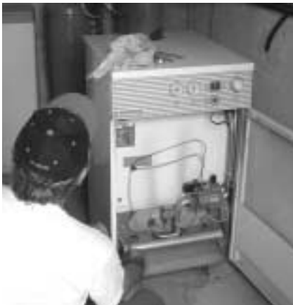
Manutenzione della caldaia - Foto Afpt
