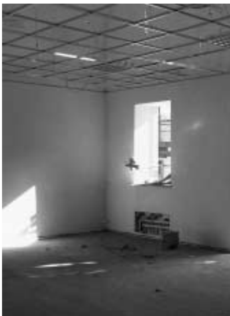
Corpo ex scuderie, posizionamento strutture per controsoffitto fonoassorbente
