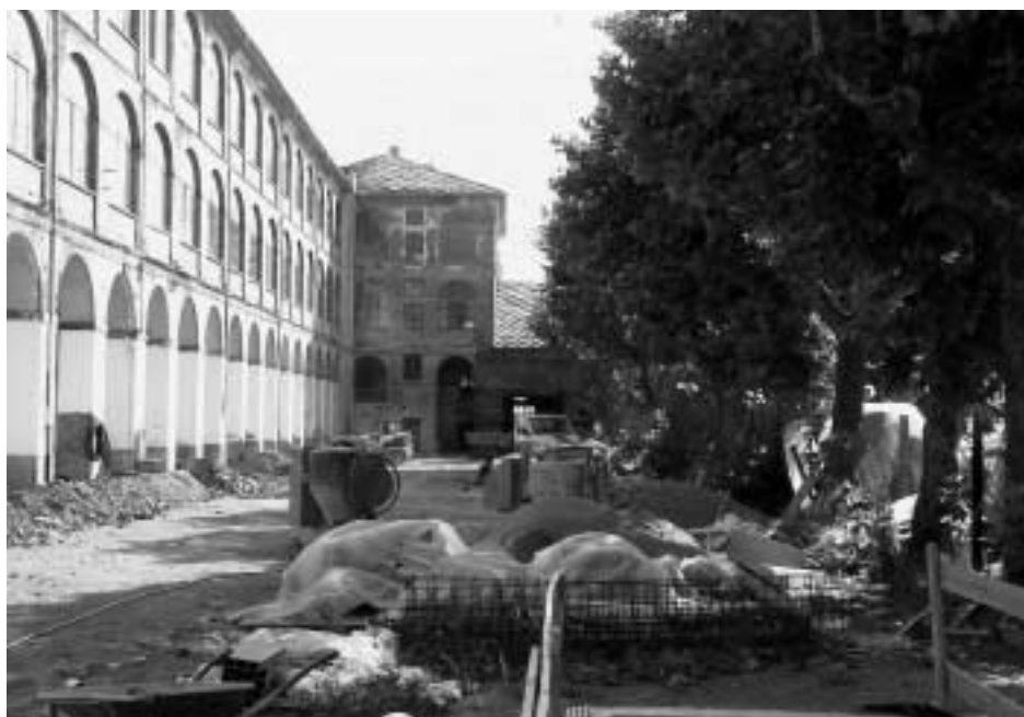
Lavori di ristrutturazione dell'ex caserma "Fenulli" a Pinerolo, da adibire a sede del liceo classico-linguistico "G. F. Porporato" - Sistemazione area esterna
