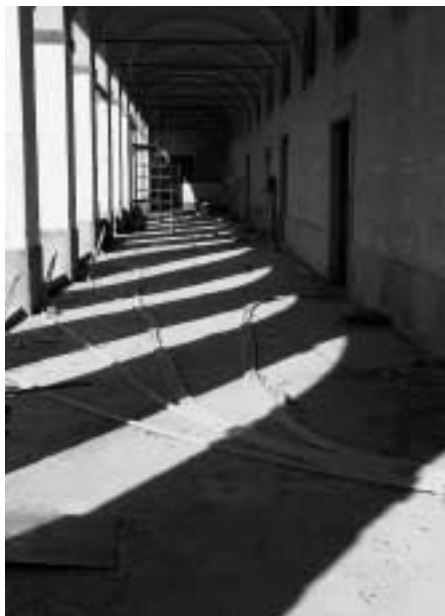
Corpo principale, realizzazione impianto termico
