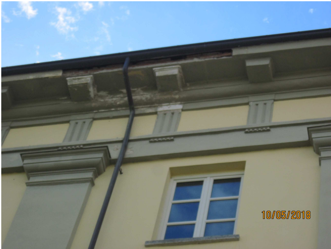
Degrado dei cornicioni per versamento dai canali di gronda
