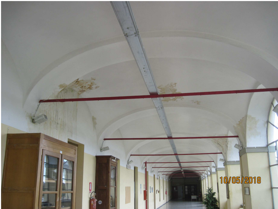
Infiltrazioni dalle volte del secondo piano
