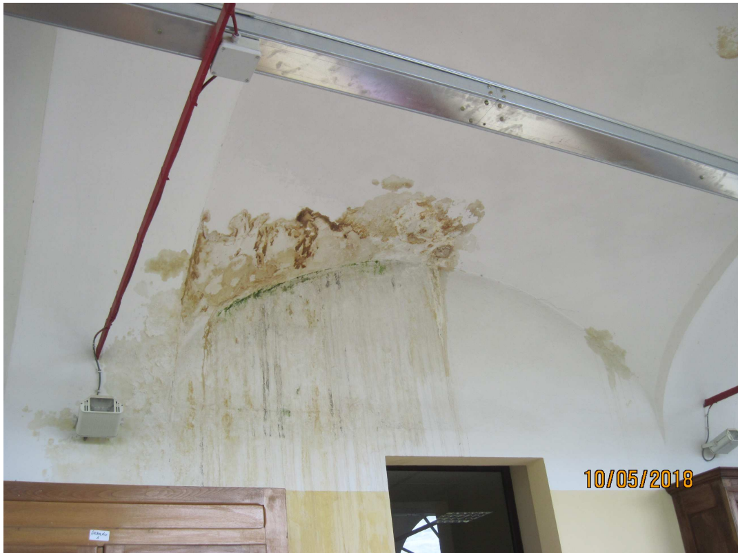
Infiltrazioni dalle volte del secondo piano
