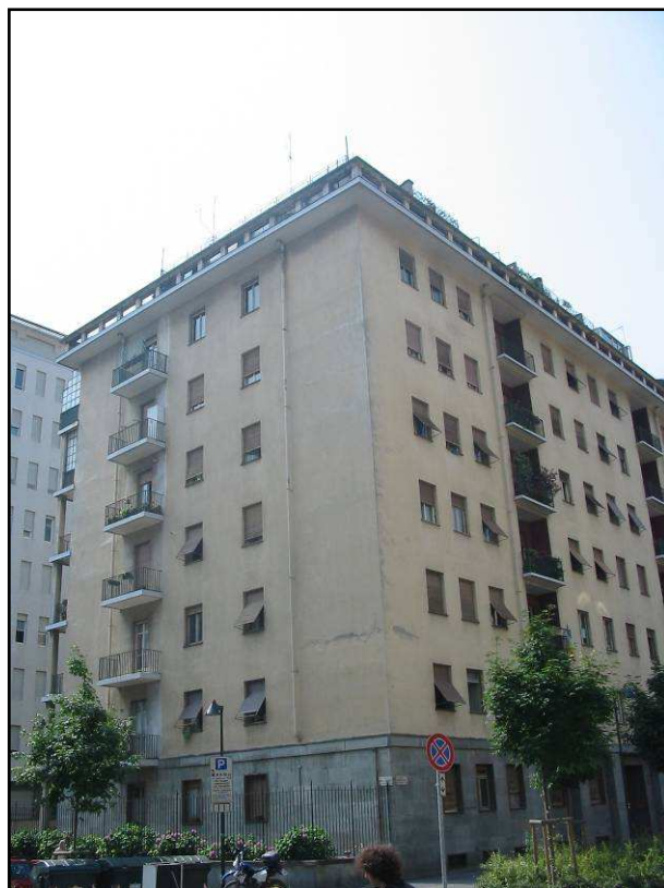
Prospetto via D'Ovidio – via Peano
