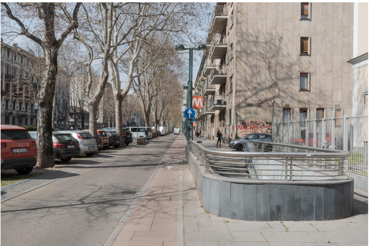
Fig. 50 – Metro M1 Fermata Principi D'Acaja accesso secondario - inserimento architettonico – Torino
