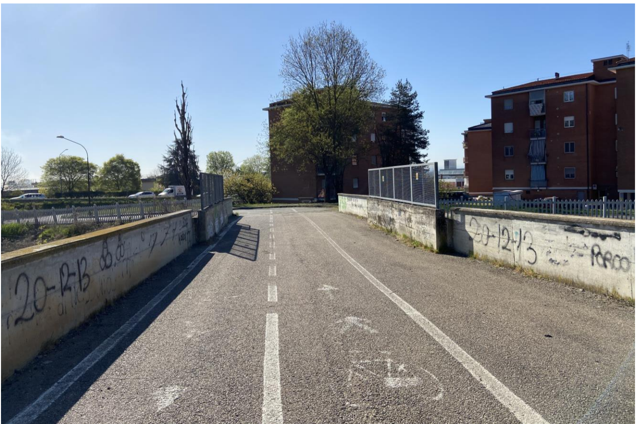
Fig. 20 – Ponte ciclopedonale sulla ferrovia – Chieri 08/04/2021 META
