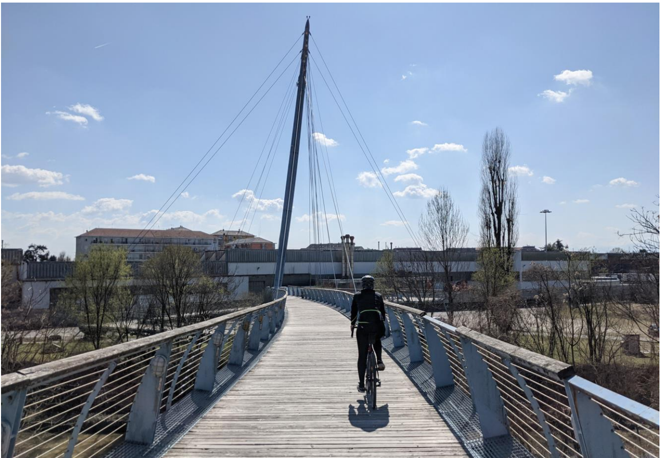
Fig. 4 – Passerella ciclopedonale – Beinasco 20/03/2020 META
