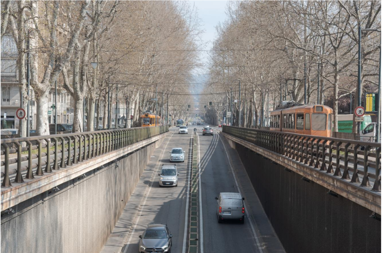
Fig. 51 – Tram Corso Regina Margherita – Separazione flussi di traffico – Torino 25/03/2021 META
