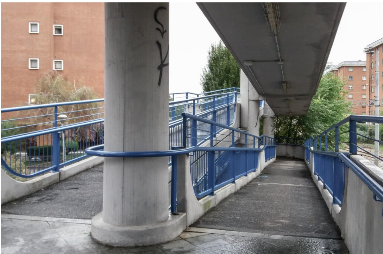
Fig. 10 – Passerella ciclopedonale sovrappasso stazione – Collegno
