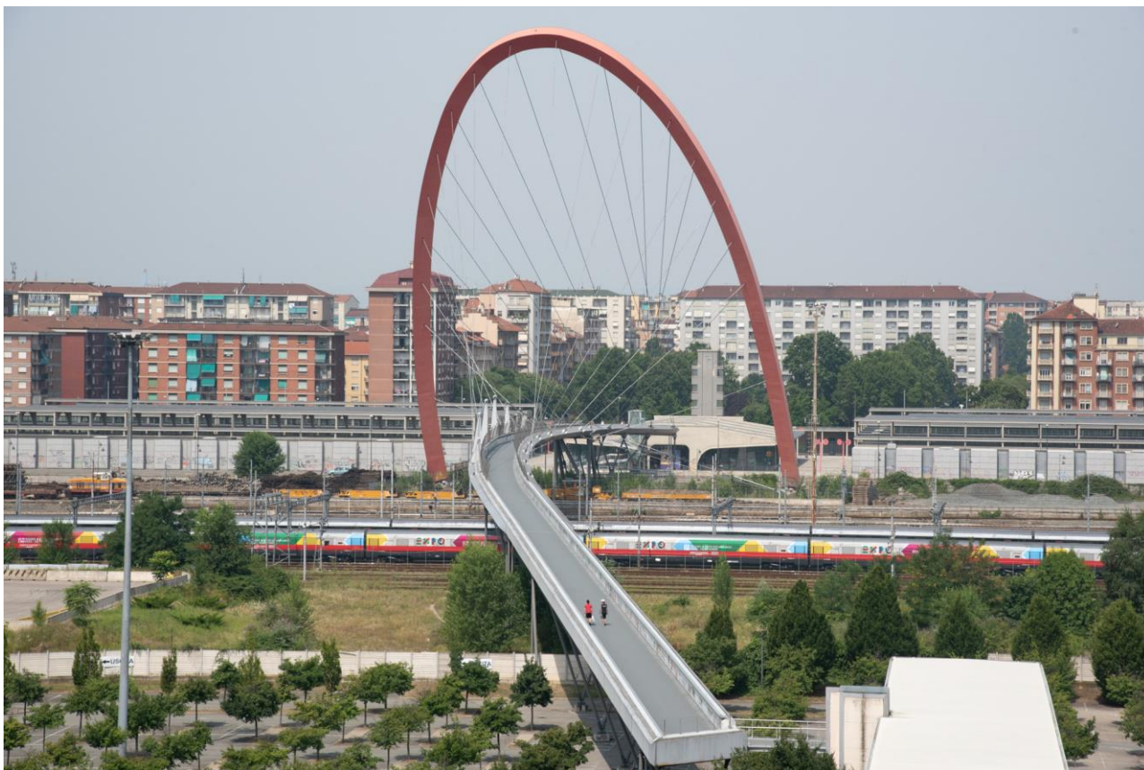
Fig. 9 – Passerella olimpica ciclopedonale Lingotto – Torino
