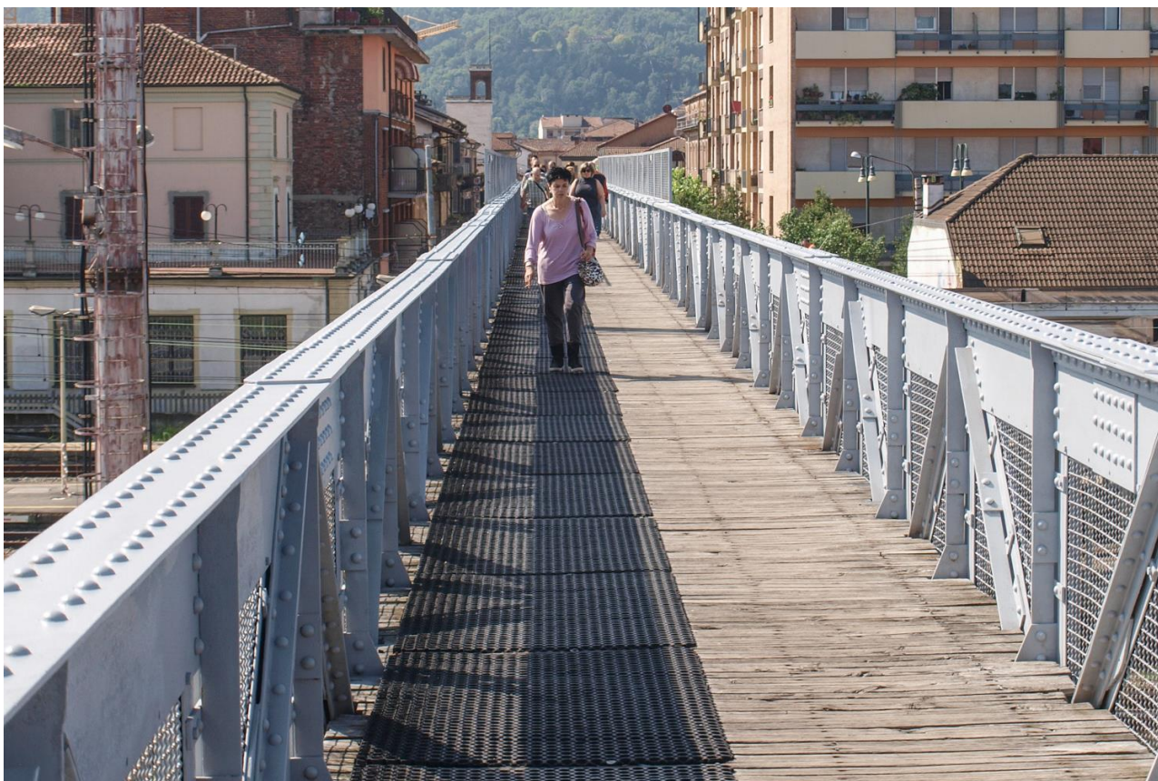
Fig. 14 – Passerella pedonale Stazione ferroviaria – Chivasso 25/03/2021 META
