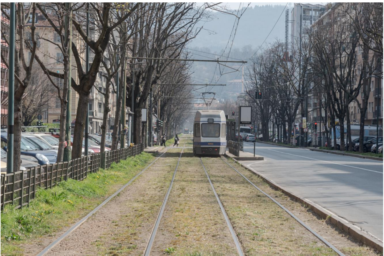
Fig. 52 – Tram Corso S. Maurizio – Separazione flussi di traffico – Torino
