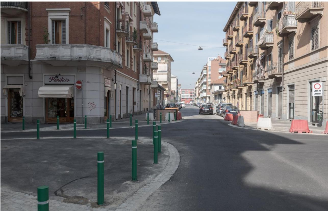
**Fig. 59 – Interventi di moderazione velocità con allargamento delle aree pedonali – San Donato Torino**
