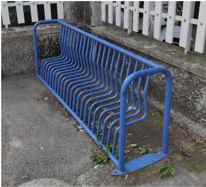
**Fig. 2.2.i – Esempio di rastrelliera senza portaruota definito-Stazione di Pont canavese Rilievo META**
