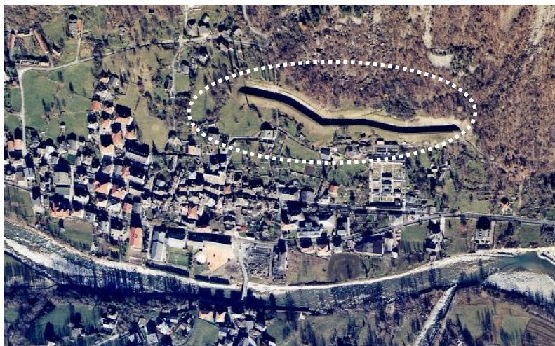
Fig. 7 – Ripresa aerea del rilevato paramassi realizzato a monte del concentrico di Locana (Volo CGR 2000).
