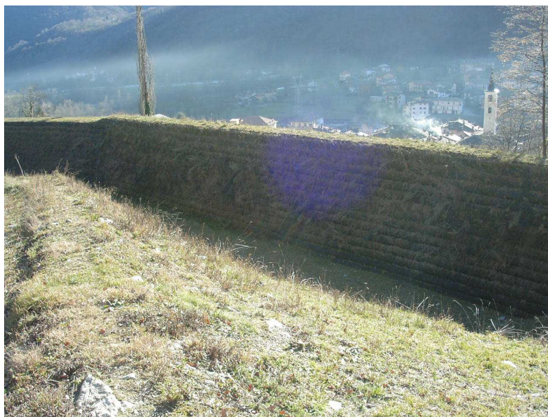
Fig. 8 – Il rilevato paramassi visto da monte.
