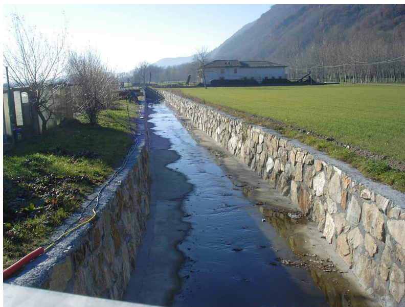
Fig. 20 – Il canale scolmatore che scorre nel settore pianeggiante del Comune di Quassolo presenta una sezione rettangolare, con sponde rivestite da scogliere in massi ciclopici e fondo in calcestruzzo.
