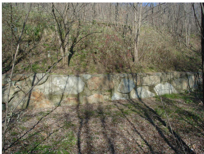
Fig. 13 – Al piede del rilevato, sul lato a valle dell’opera, è stato realizzato un muro di sostegno in massi cementati.
