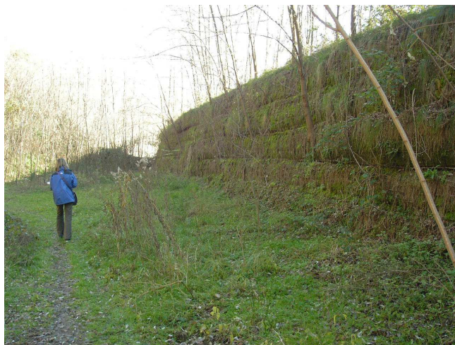
Fig. 12 – Rilevato paramassi a monte del centro abitato di Baio Dora.
