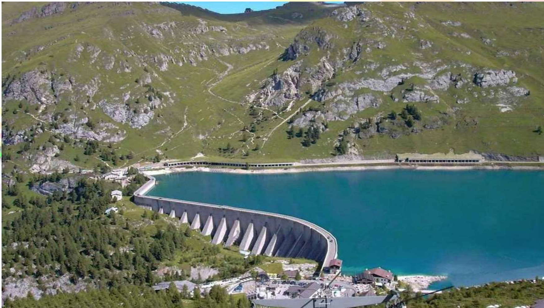
IMPIANTO IDROELETTRICO- DIGA
