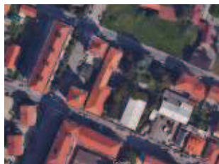
"Sede Polizia Municipale" manutenzione copertura e isolamento.
