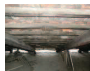
Sottotetto: miglioramento isolamento termico e intervento globale di manutenzione copertura- vedere foto seguenti.
