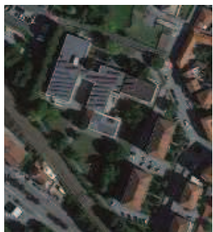
Scuola "Gramsci", manutenzione elementi prefabbricati frangisole.
