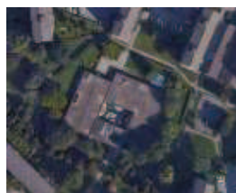
Nido e scuola "Andersen" manutenzione copertura con isolamento
