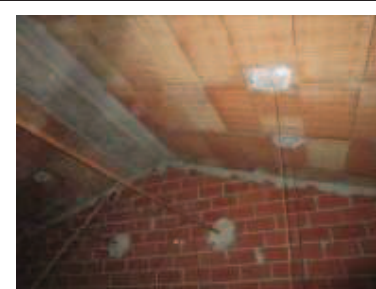
Vista insieme: vano tecnico fra "Perret" e solaio di copertura a falda.
