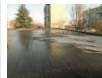
Copertura: nido e scuola Andersen.
