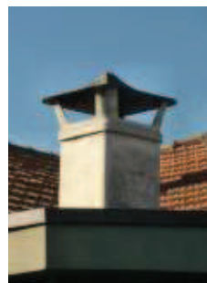
Camino sopra vano ascensore: eventuale bonifica e sostituzione.
