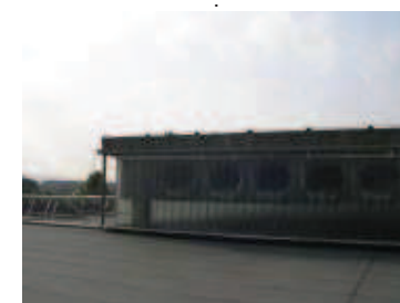
Rifacimento copertura atrio: elementi u-glass.
