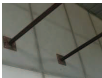
Particolare: elementi ancoraggio struttura sostegno tabelloni giuoco basket.
