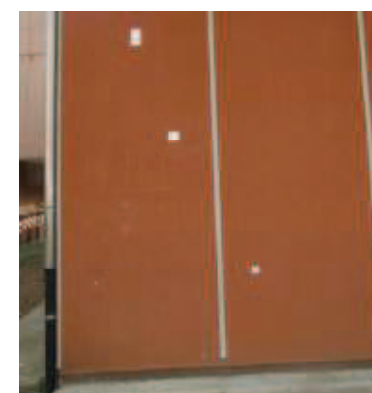
Particolare: interventi di "messa in sicurezza da dispersione fibre di pannelli di facciata".
