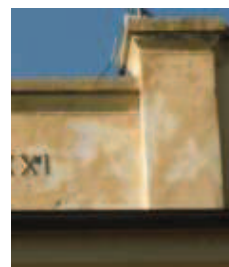
Degrado muretti di coronamento: scuola E. De Amicis.
