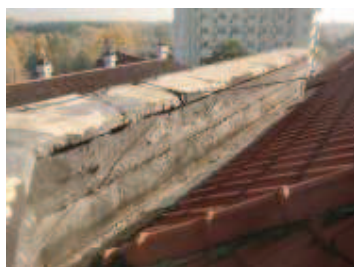
Degrado: muretti di coronamento e canale di gronda interno.
