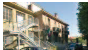
Vista esterna fabbricato: sede della Polizia Municipale.
