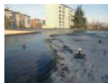
Copertura: nido e scuola Andersen.
