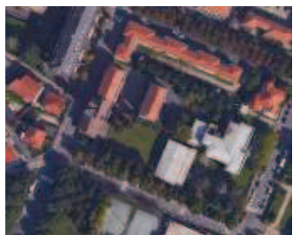
Intervento realizzazione della nuova palestra della scuola 8 Marzo .
