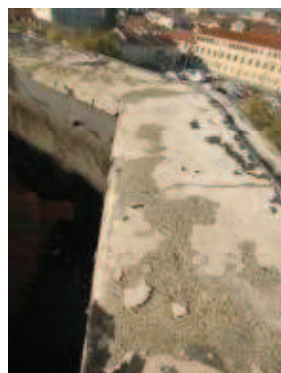
Degrado muretti di coronamento: scuola E. De Amicis.
