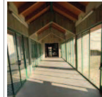
Corridoio: collegamento fra la scuola e la palestra, adeguamento antincendio.
