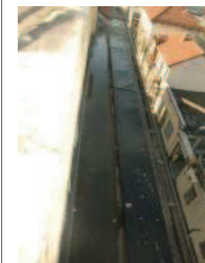
Canale di gronda in cornice: scuola E. De Amicis.
