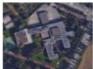
Scuola " Don Milani " lavori di prevenzione incendi, auditorium e palestra, ripristino funzionalità docce e spogliatoi palestra.
