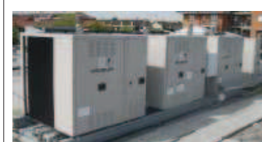
Scuola "Gallo Praile" gruppo caldaie in copertura.
