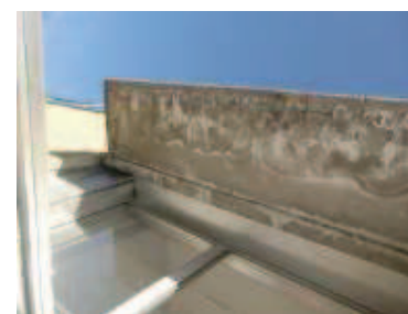
Prospetti: veelette frangisole con ferri esposti degrado del cemento segni, necessario intervento.
