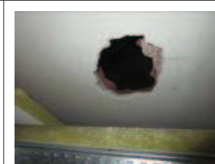
Piano primo: alcuni locali presentano intradosso in muratura realizzato dall'accostamento di tavelle "Perret" e controsoffitto in fibra minerale.
