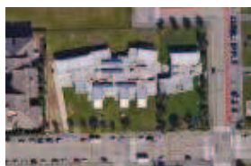
Scuola "Gallo Praile": manutenzione copertura e completamento pensilina perimetrale
