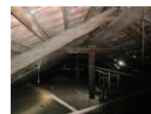
Sottotetto: necessita di manutenzione.
