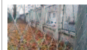
Dettaglio recinzione: Ex Omni.
