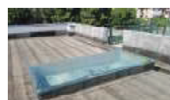
Protezione lucernari: copertura "area amministrativa" e realizzazione camminamento.
