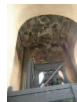
Degradato interno del soffitto della cella campanaria.
