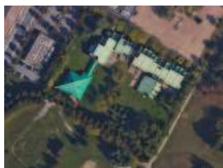
Palestra Romero adeguamento antincendio.
