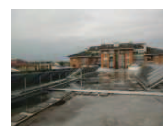
Scuola "Gallo Praile" copertura: ristagni di acqua nella zona centrale.
