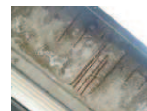
Particolare degrado: veelette assenza copriferro, ferri ossidati.
