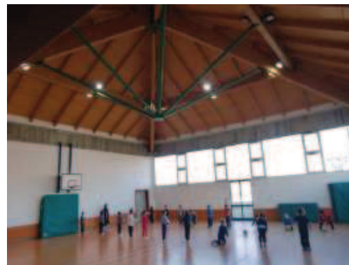
Palestra: Verniciatura elementi lignei e metallici della copertura.
