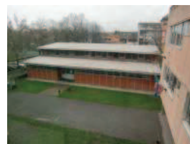
Vista complessiva della palestra: oggetto di bonifica e demolizione.
