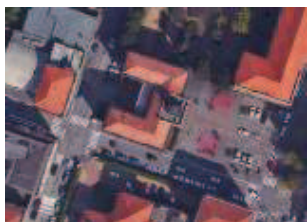
Palazzo civico , Interventi sulla copertura
