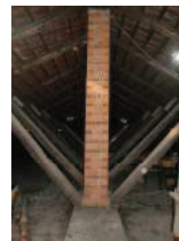
Sottotetto: necessita di manutenzione.
