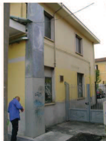
FOTO 7 - Prospetto est Edificio 2
