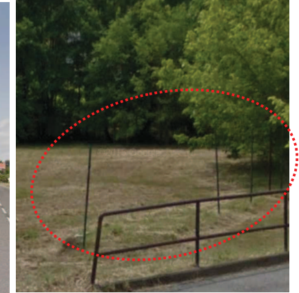
RECINZIONE DA SOSTITUIRE
