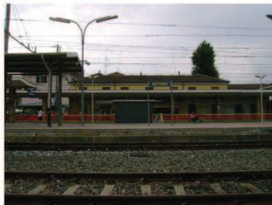
FOTO 8 - Prospetto sud Edificio 1
