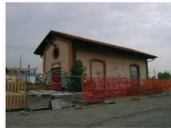
FOTO 17 - Vista d'insieme dell'edificio magazzino (Ed3)
