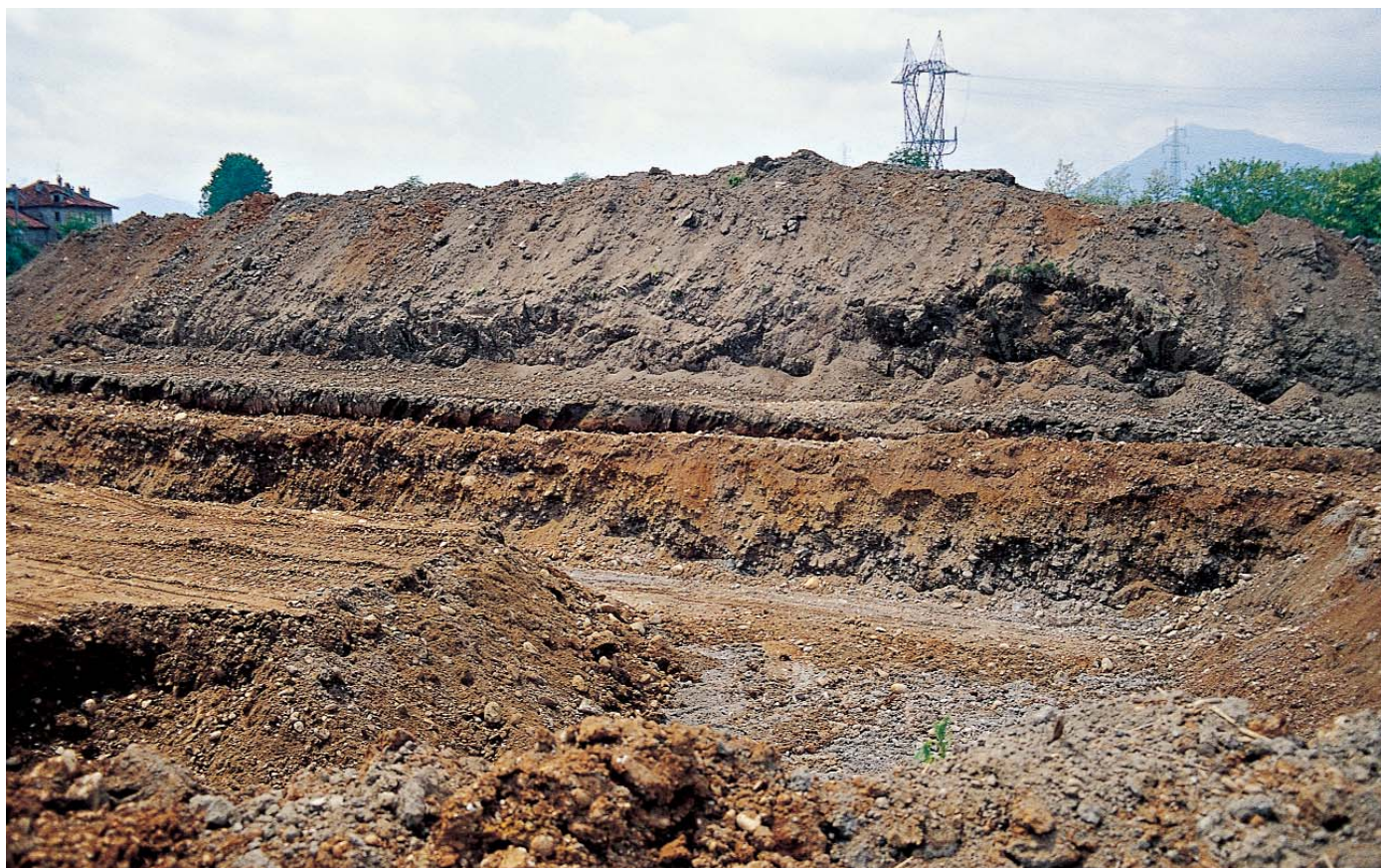
25. Prezioso suolo agrario asportato durante i lavori per la costruzione di un nuovo svincolo sulla tangenziale di Torino (Collegno), giugno 2004 (f. L. Mercalli).
