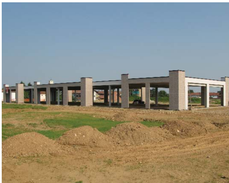
34 a, b - Cantieri di nuove costruzioni destinate a commercio e servizi alla periferia di Rivarolo Canavese (primavera 2008, f. D. Cat Berro).
